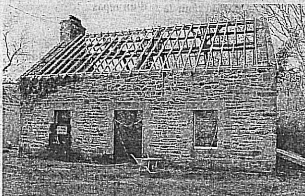
Le toit de l'ancienne crêperie a été déposé. Il sera recouvert cet hiver.
