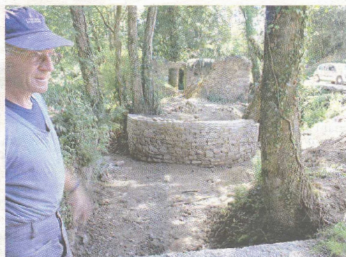
Jean-Paul Chapron apprécie la qualité du travail accompli (au centre : le moulin et le mur de séparation des deux biefs)
