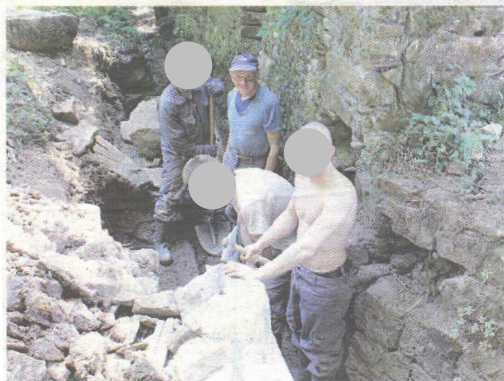
Les jeunes ont dégagé les deux biefs.
